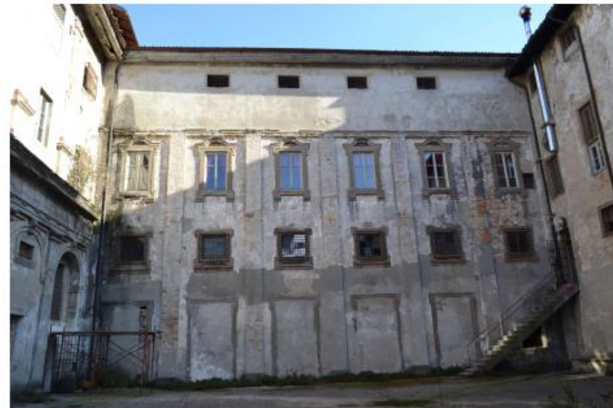
Corpo Est. Oggetto di intervento di riqualificazione
